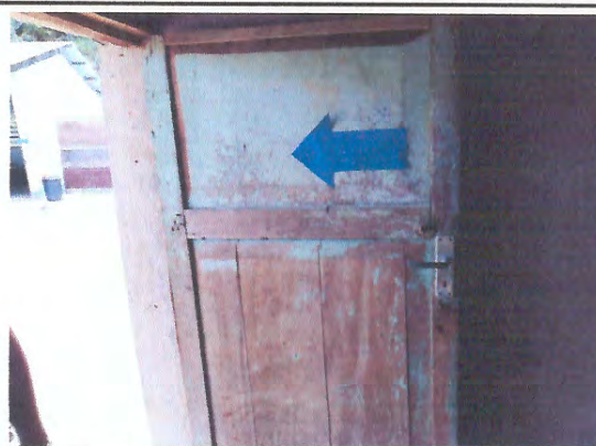
Foto 2: Mejoramiento e instalaciones de puertas metálicas modulo 3.
