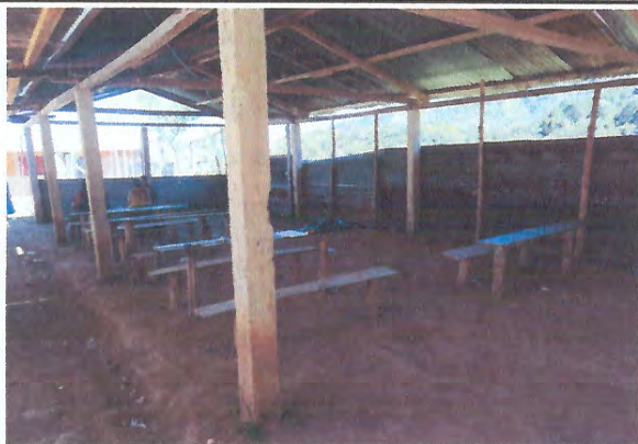
Foto 1: Mejoramiento de modulo 1
